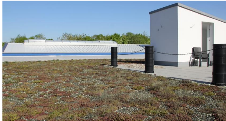
Bild 5: Gründach auf dem Hauptgebäude
