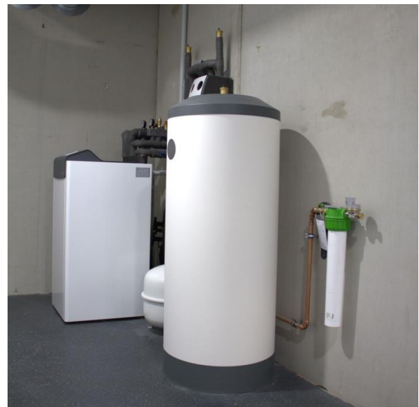
Bild 8: Zentrale Wärmepumpe
