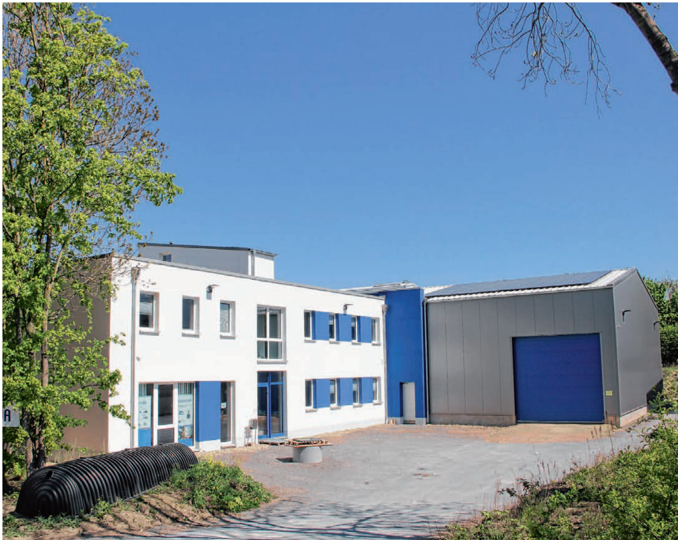
Weiß, blau und vor allem grün: Das Firmengebäude der INTEWA GmbH in Aachen auf der Hüls ist energieneutral, wasserautark und zugleich kostengünstig.
